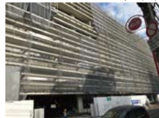
建設中の新本庁舎2020.1月
